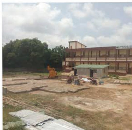
Construction d'un bâtiment R+1 au Centre des métiers de Ouidah au Bénin.
